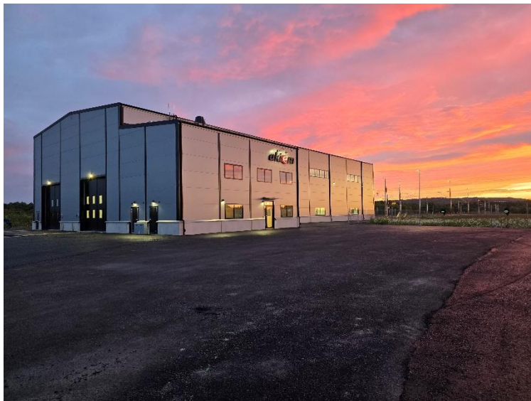
Atelier Akiem Maintenance & Services à Borlänge, Suède
